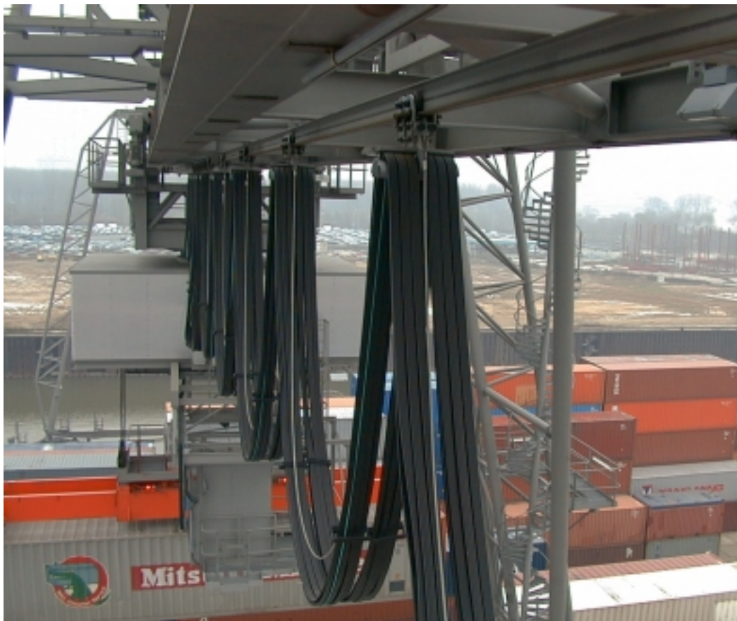
Рисунок 4-11 Использование PROFIBUS кабеля для гирляндного монтажа
